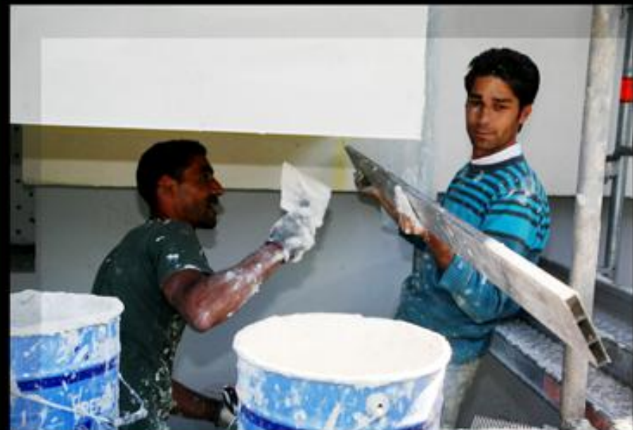
Mehmet, 40 ans, poseur d'isolation, Entreprise BEKCI, La Ravoire
