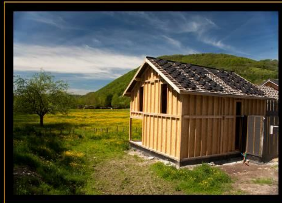
deux maisons mitoyennes en ossature bois à Chirens, triple vitrage, panneaux photo-voltaïques, chauffe-eau solaire...
