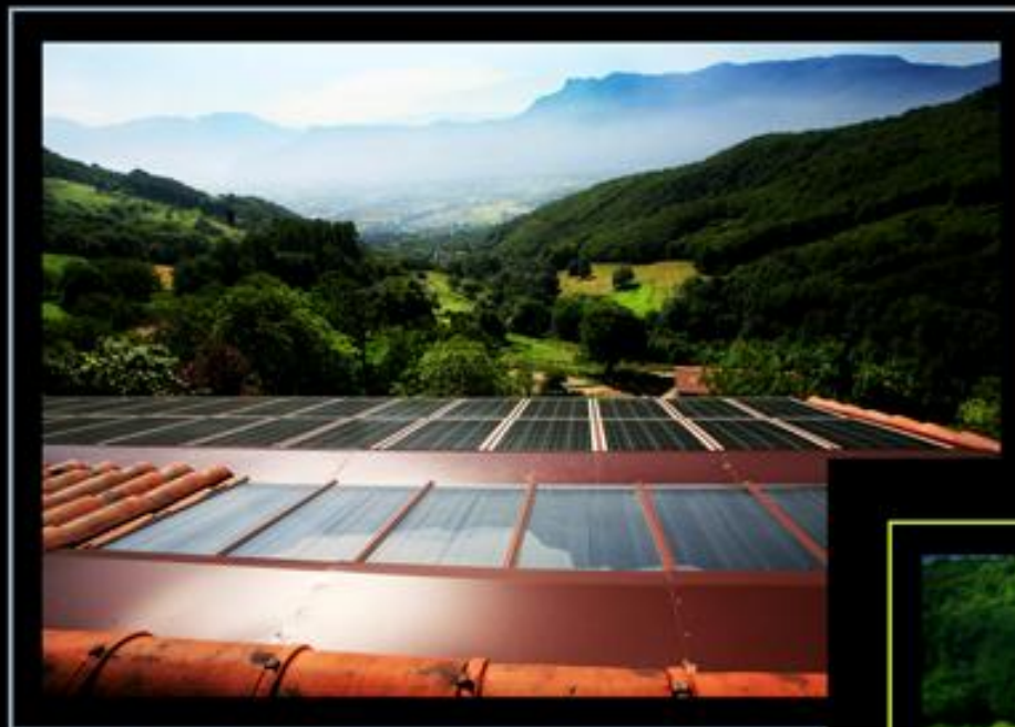
Maison individuelle de Mme et M Riccardi, Tullins: pose de panneaux photovoltaïques (électricité) + panneaux solaires thermiques (chauffe-eau)
