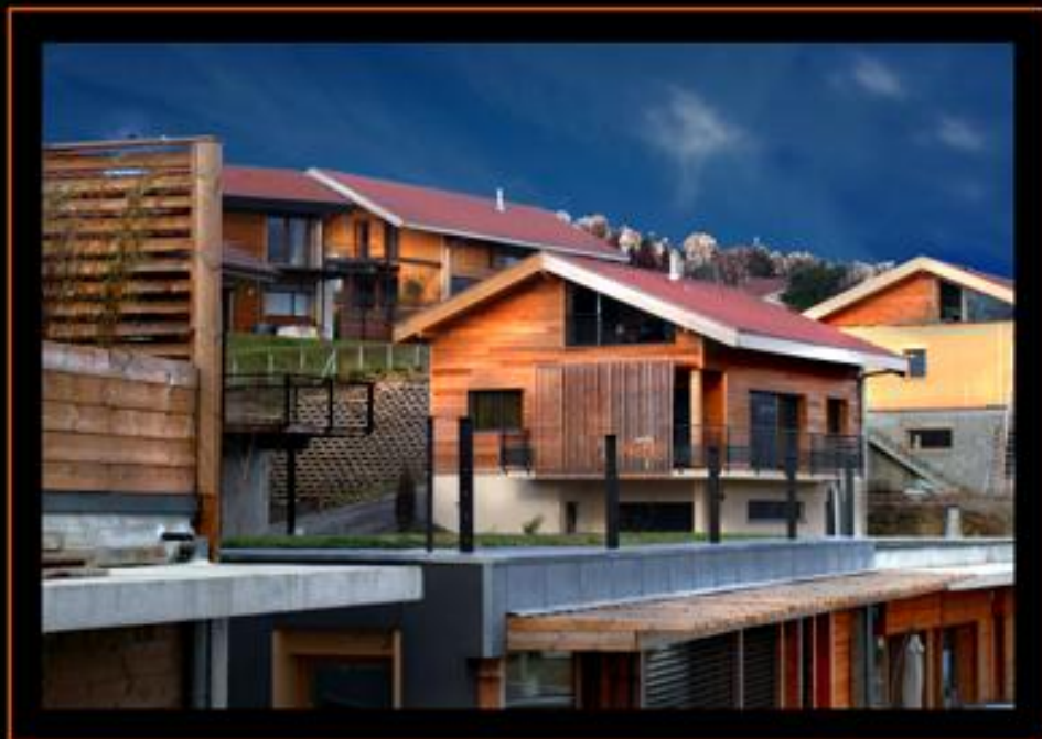
lotissement éco-construit de l'îlot des Cornelles à Saint Jean de Moirans : construction bois, toitures végétalisées, isolation ouate de cellulose
