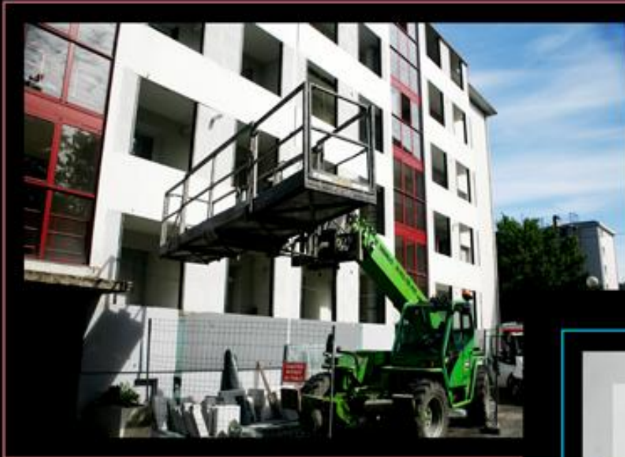
Isolation thermique par l'extérieur d'un habitat collectif, immeuble Painlevé, Pluralis, Voiron
