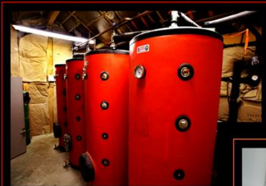
Installation d'une chaudière alimentée par des panneaux solaires, immeuble Painlevé, PLURALIS, Voiron
